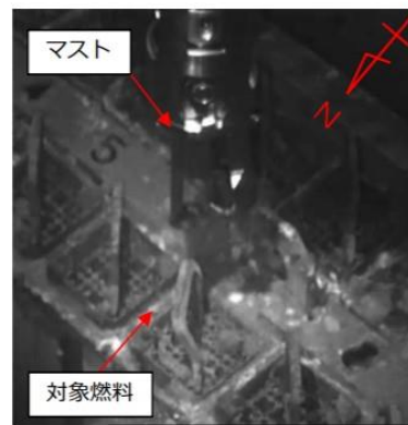
マスト 対象燃料 マストと配管の干渉により 吊ることができない燃料 (No.⑭※)
