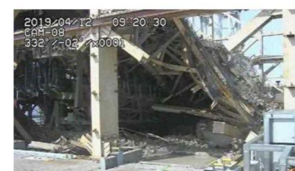
小ガレキ撤去状況
