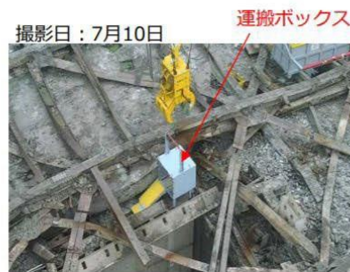
写真① 運搬ボックス設置状況
