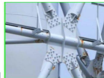
健全と判断した箇所の例
