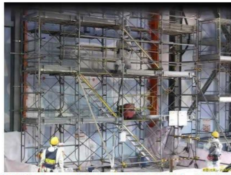
調査用コア採取の作業状況(全景)
