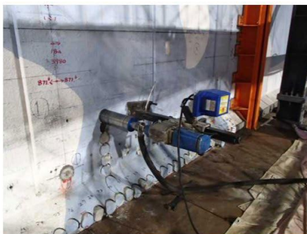
解体用コア削孔 (STEP3) 2018/4/24撮影
