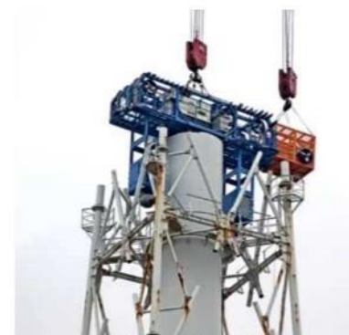
搭乗設備 作業状況
