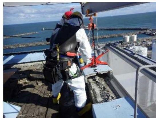
屋上での桁木撤去状況
