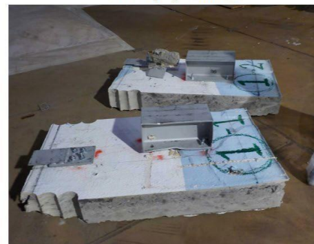
壁解体 (STEP6) 2018/5/28撮影
