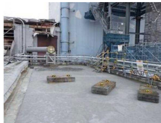
FSTR建屋片付け状況
