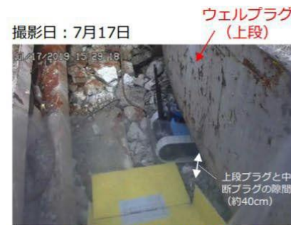
写真② 内部への侵入状況 (運搬ボックス内のカメラから撮影)
