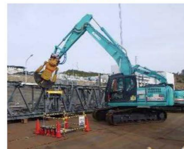
上部解体時の小割解体状況 撮影：2017.4
