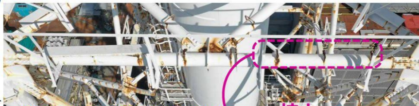
【写真①】 地上約76mの南側水平材
