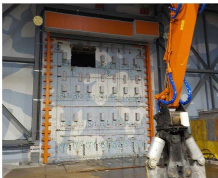
壁解体(STEP6) 2018/5/28撮影
