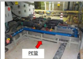
新規PE管施工後
