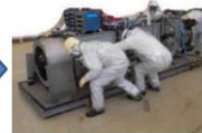
堆積物除去装置 (低圧水) 撤去
