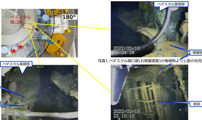
写真2.ペDESTAL開口部(左側基礎部)の堆積物を堺にした上下部の状況
