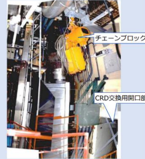
【震災前：定期検査時】CRD交換用開口部前 チェーンブロック CRD交換用開口部
