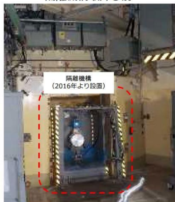
隔離機構取外し前
