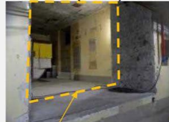
【ブロックアウト撤去後】(矢視B)
