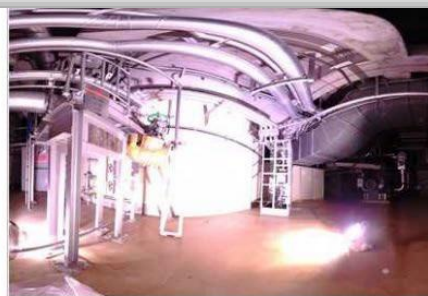
3階シェル壁北東面 (写真)
