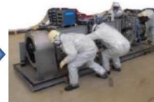
堆積物除去装置 (低圧水) 撤去
