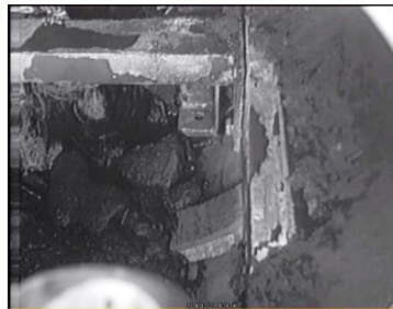
高圧水施工後 (X-6ペネ右下部)
