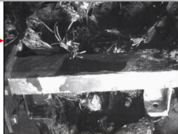
高圧水施工後 (X-6ペネ中央部)
