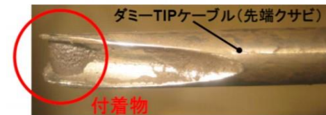
2号機 T I P 配管内閉塞物
