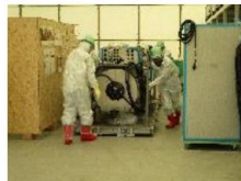
堆積物除去装置 (高圧水、AWJ) 設置
