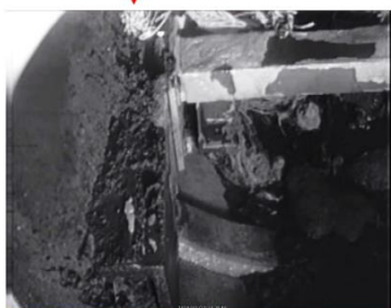
高圧水施工後 (X-6ペネ左下部)
