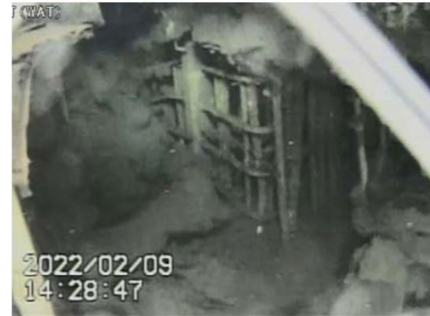
A. ペDESTAL開口部付近
