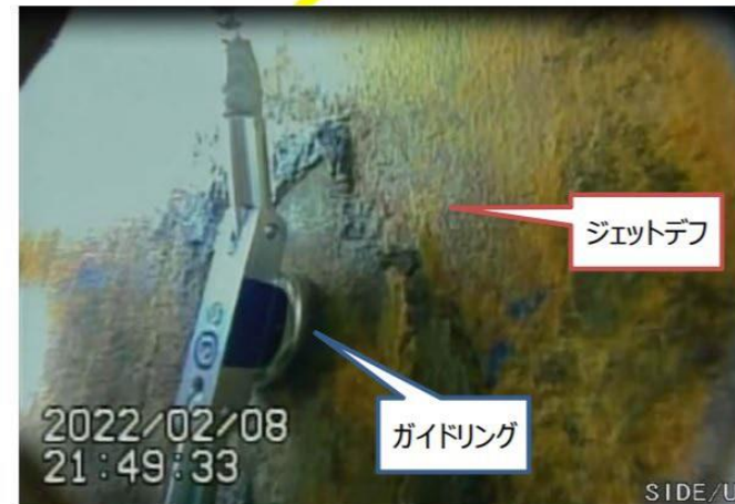
ガイドリング③設置状況 (2月8日午後9時49分設置完了)
