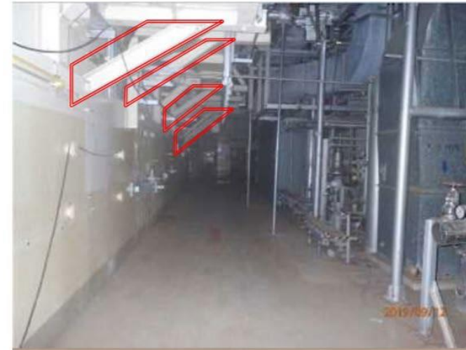
赤枠：対象機器 2号機原子炉建屋1階（西側）
