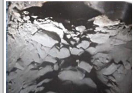
(写真上) 低圧水による除去作業前の貫通部上部 = 16日、(写真下) 除去作業後の貫通部上部 = 18日の作業前 (東電提供)
