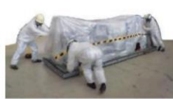
堆積物除去装置 (高圧水、AWJ) 撤去
