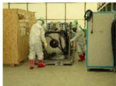
堆積物除去装置 (高圧水、AWJ) 設置
