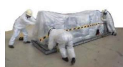
堆積物除去装置 (高圧水、AWJ) 撤去
