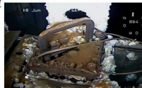
ワイヤー修復燃料上部の様子
