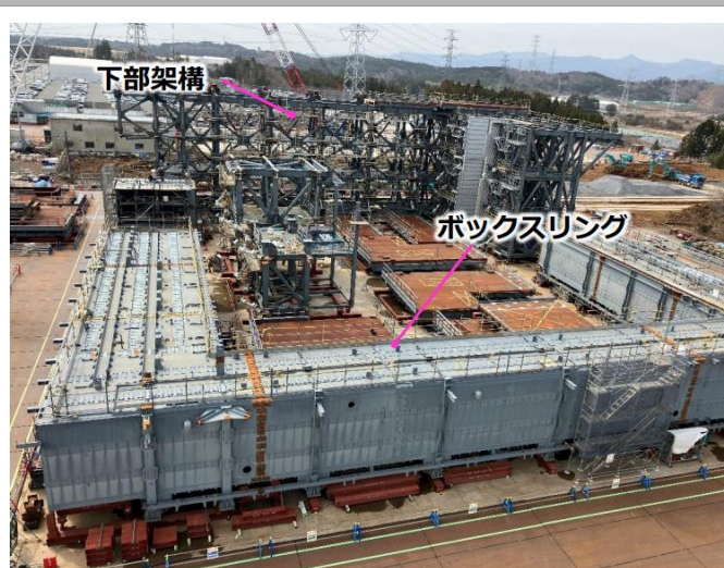
構外ヤード全景 (撮影: 2024年3月25日)
