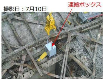
写真① 運搬ボックス設置状況
