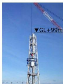
9ブロック解体後 (2020年1月17日)
