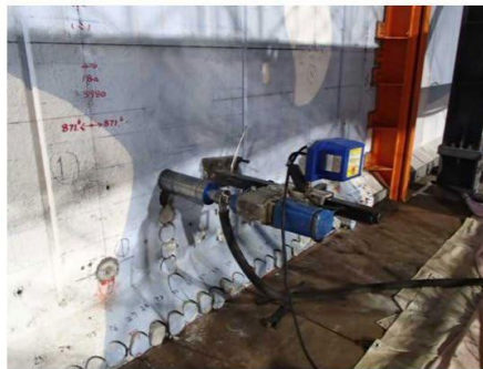
解体用コア削孔 (STEP3) 2018/4/24撮影
