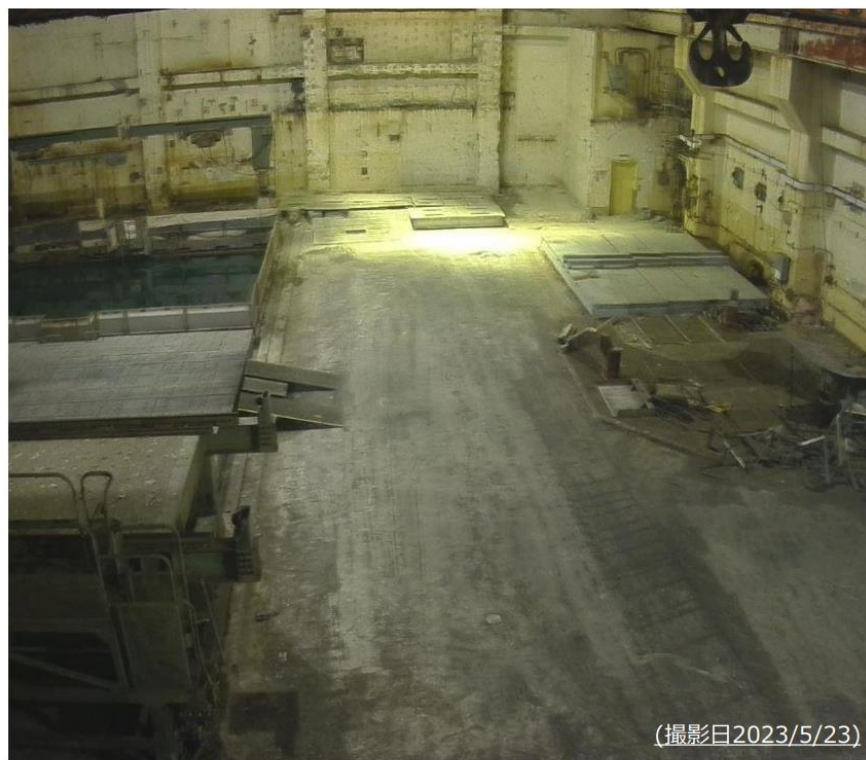
作業進捗状況
