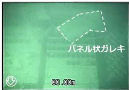
写真① (水中1m 斜め下方向)
