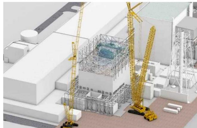
仮設構台設置完了
