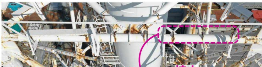
【写真①】 地上約76mの南側水平材
