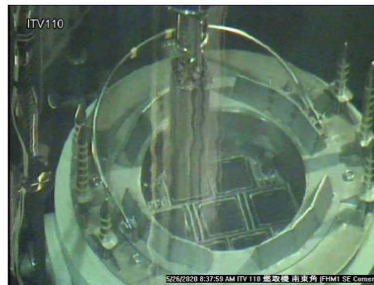
使用済み燃料の輸送容器への装填状況
