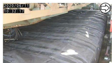
エアモルタル充填 (撮影日: 2020.6.11)
