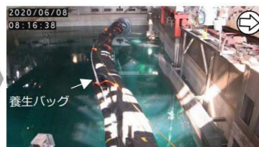
養生バッグ投入 (撮影日: 2020.6.8)
