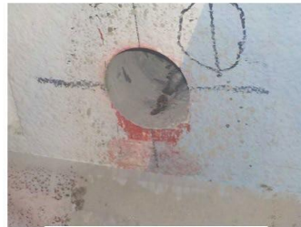
調査用コア採取の状況
