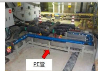
新規PE管施工後
