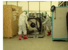
堆積物除去装置 (高圧水、AWJ) 設置
