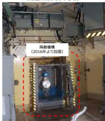
隔離機構取外し前
