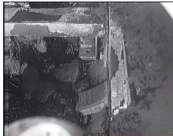
高圧水施工後 (X-6ペネ右下部)
