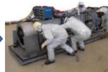
堆積物除去装置 (低圧水) 撤去
