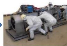
堆積物除去装置 (低圧水) 撤去
