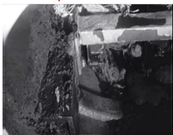
高圧水施工後 (X-6ペネ左下部)
