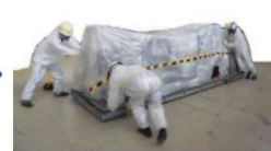
堆積物除去装置 (高圧水、AWJ) 撤去
