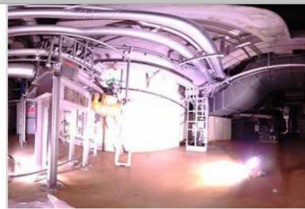
3階シェル壁北東面 (写真)
