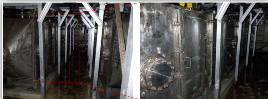
4号機SGTSフィルタレインの様子
