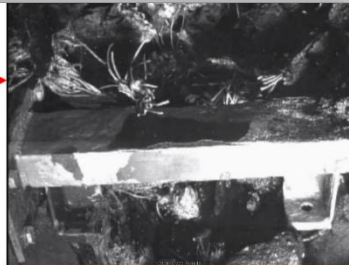
高圧水施工後 (X-6ペネ中央部)
