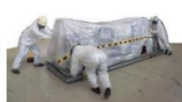
堆積物除去装置 (高圧水、AWJ) 撤去
