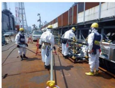
写真③ ケーブル敷設作業状況
