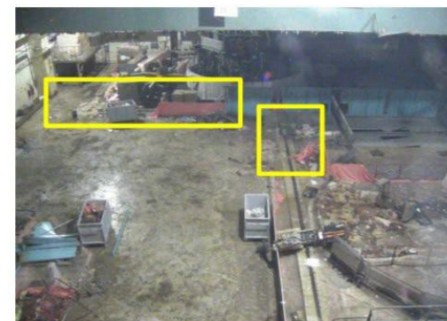
②残置物移動片付後（北側）
