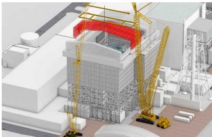
可動屋根設置中
