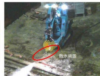
① 散水状況 (ダスト抑制対策)
