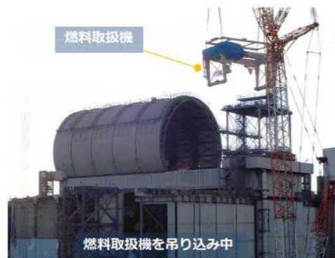
燃料取扱機、ガーダ上への設置状況 (撮影日2017年11月12日)
