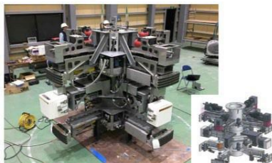
筒身解体装置 組立状況
