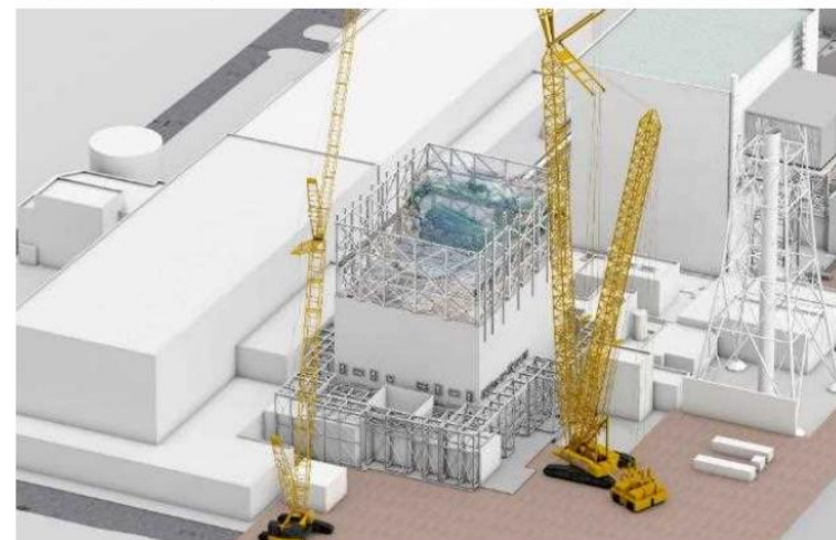
仮設構台設置完了
