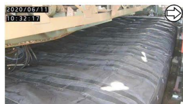
エアモルタル充填 (撮影日: 2020.6.11)
