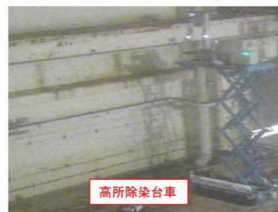
⑤高所空間／表面線量率測定状況
