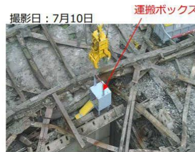
撮影日：7月10日 写真① 運搬ボックス設置状況
