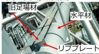
【参考】 改造工事前の足場写真 (昭和61年撮影)
