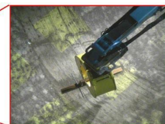
清掃用ブラシを用いて、床面の遊離性ダスト (砂等) を集め、集塵機で回収を行う。
