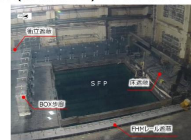
オペフロ東側SFP周辺状況 (撮影日: 2024/1/15)
