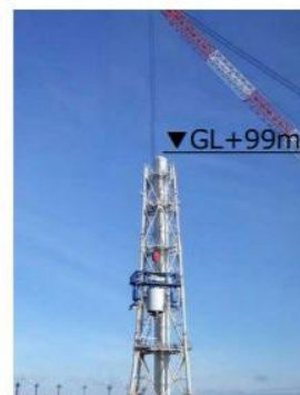
9ブロック解体後 (2020年1月17日)
