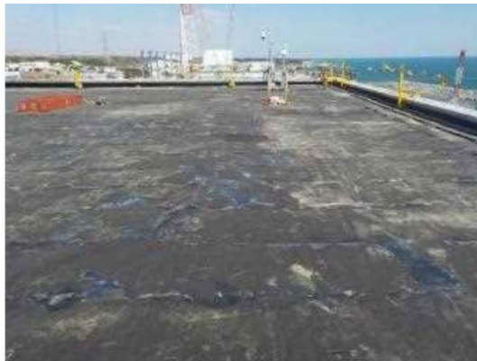
2R/B上屋対策状況
