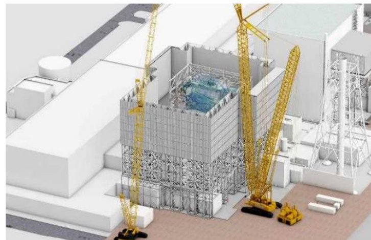
上部架構設置完了
