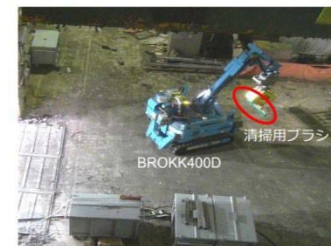
② 床面清掃状況
