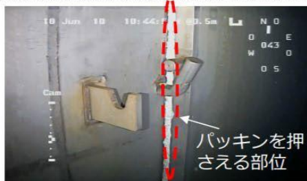
プールゲート支持軸の様子
