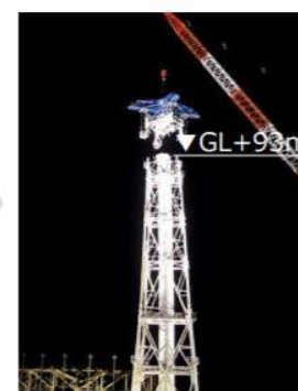
11ブロック解体時 (2020年2月1日)
