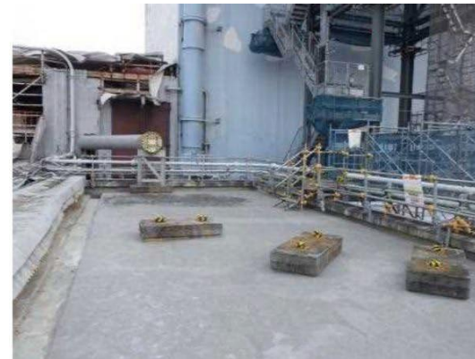
FSTR建屋片付け状況
