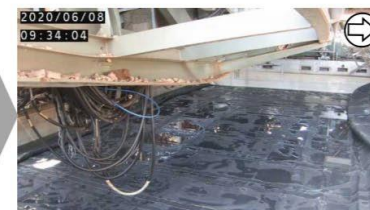
養生バッグ展張 (撮影日: 2020.6.8)
