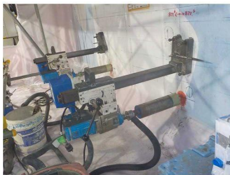
コア削孔装置設置状況
