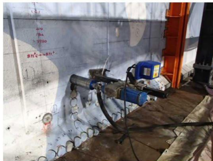
解体用コア削孔 (STEP3) 2018/4/24撮影
