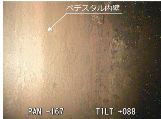
撮影場所D ペDESTAL内壁面
