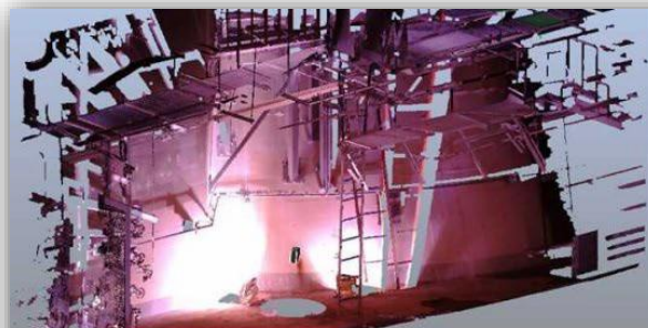
2階シェル壁東面 (点群データ)
