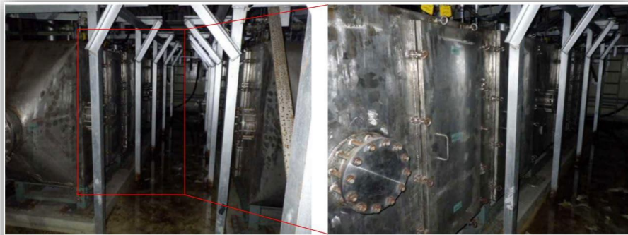
4号機SGTSフィルタレインの様子
