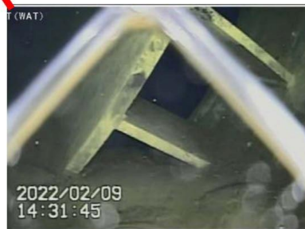
PCV東北東付近の状況（近接）
