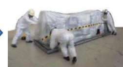
堆積物除去装置 (高圧水、AWJ) 撤去
