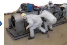
堆積物除去装置 (低圧水) 撤去
