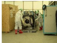
堆積物除去装置 (高圧水、AWJ) 設置
