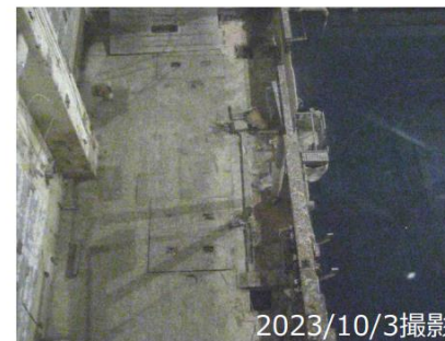
除染実施後の状況 (南面)
