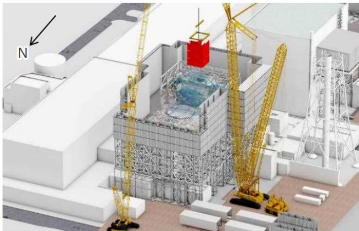
上部架構設置中
