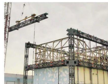
上部解体時の梁取り外し状況 撮影：2017.7
