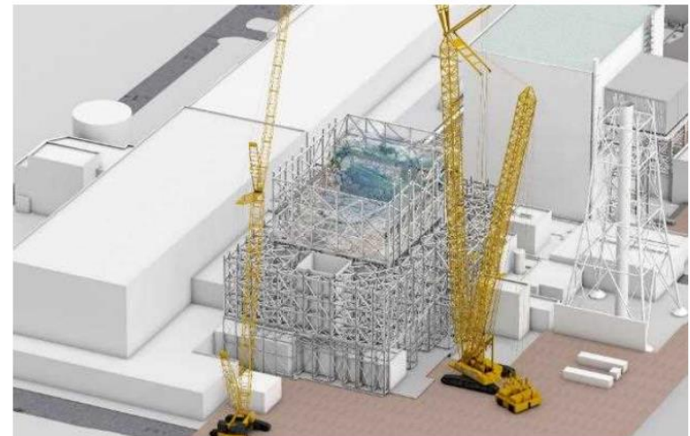
下部架構設置完了
