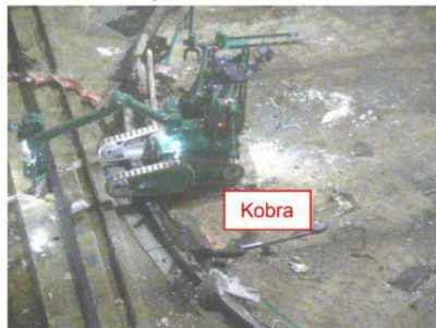
④低所表面汚染測定状況
