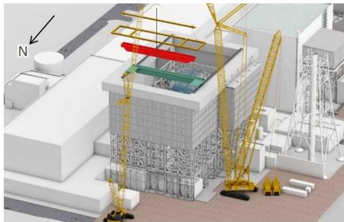
ガレキ撤去用天井クレーン設置中
