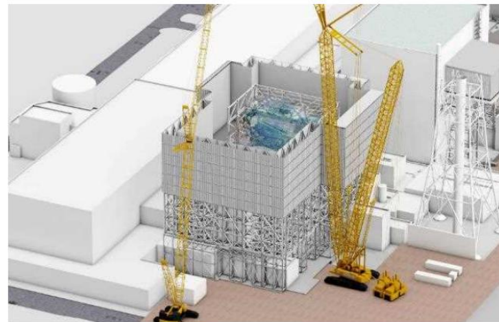
上部架構設置完了
