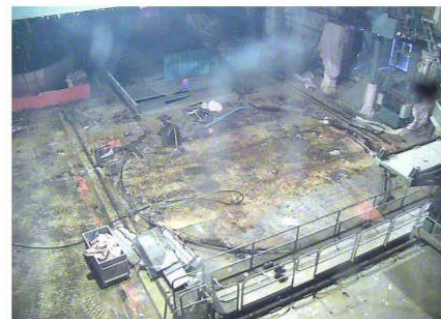
①残置物片付後（ウエル上）撮影日(10/22)
