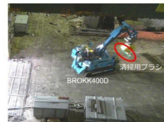
② 床面清掃状況
