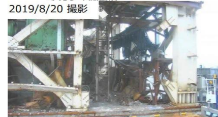
南側小ガレキ撤去後
