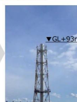
11ブロック解体後 (2020年2月4日)
