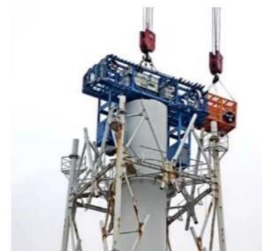
搭乗設備 作業状況
