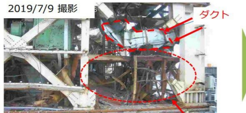
南側小ガレキ撤去前 既設架台等
