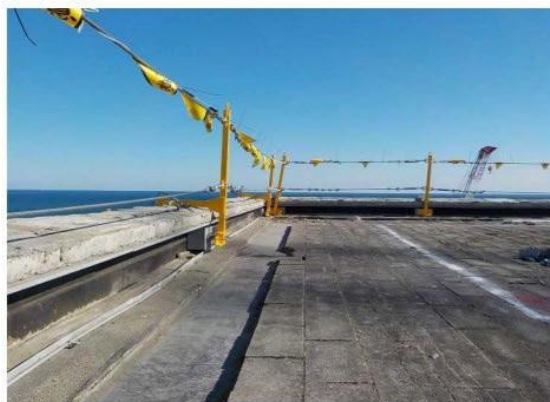
笠木等撤去後の手摺り設置状況
