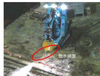
① 散水状況 (ダスト抑制対策)
