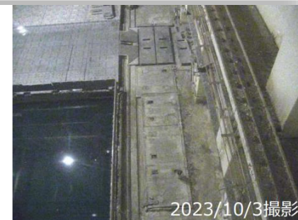
除染実施後の状況 (東面)
