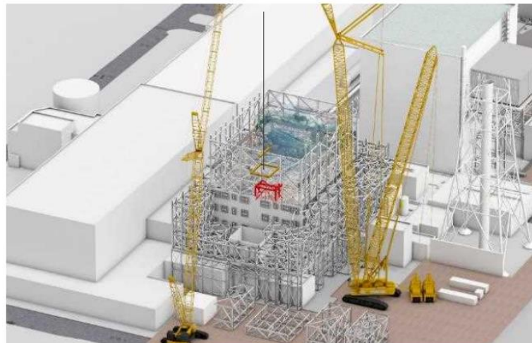
下部架構設置中
