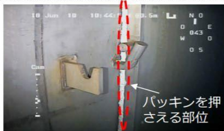
プールゲート支持軸の様子
