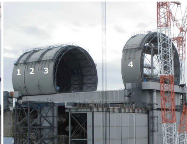
ドーム屋根設置状況 (撮影日:2017年10月25日)
