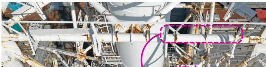
【写真①】 地上約76mの南側水平材
