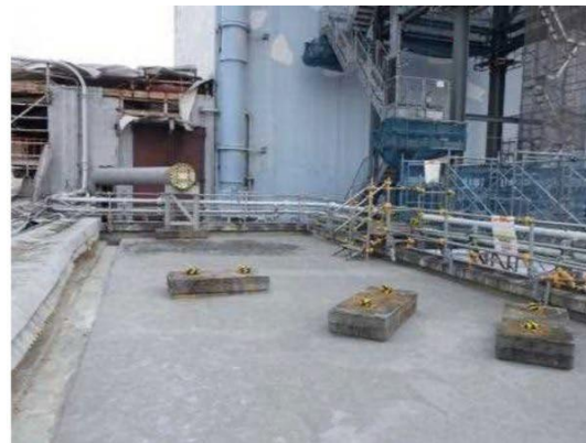
FSTR建屋片付け状況
