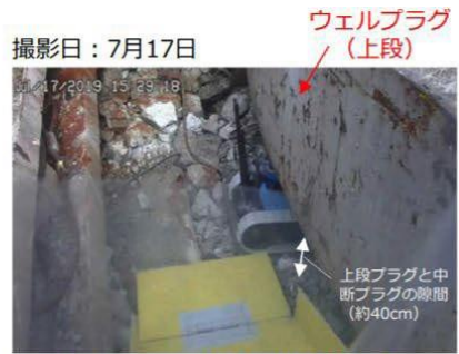
写真② 内部への侵入状況 (運搬ボックス内のカメラから撮影)
