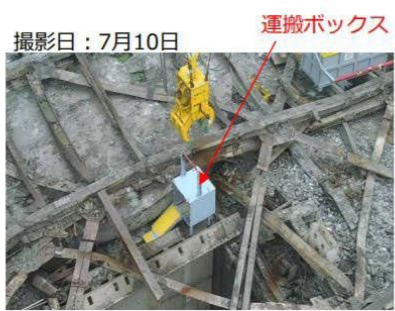
写真① 運搬ボックス設置状況
