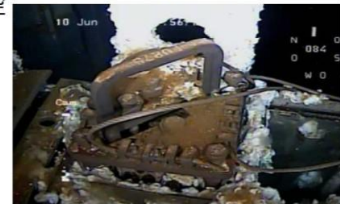
ワイヤー修復燃料上部の様子
