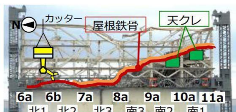
図1 崩落屋根形状(西面より)
