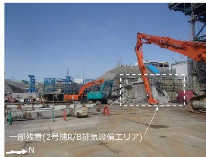
共用ボイラ建屋解体後(2020年3月撮)
