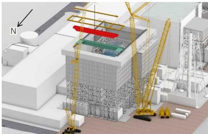
ガレキ撤去用天井クレーン設置中
