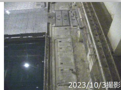
除染実施後の状況 (東面)
