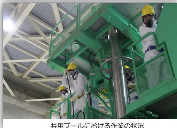
共用プールにおける作業の状況
