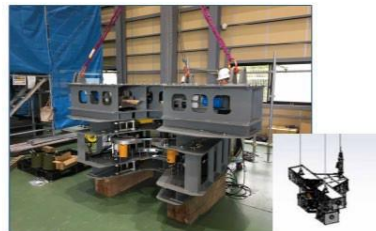
鉄塔解体装置（支柱材用）組立状況
