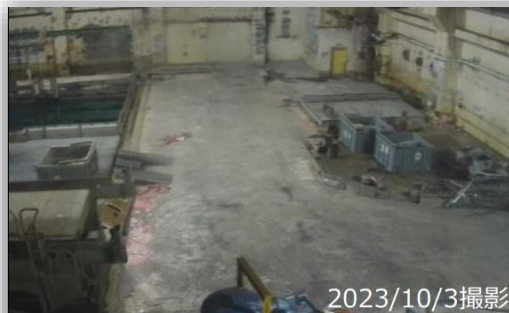
除染実施後の状況 (西面)
