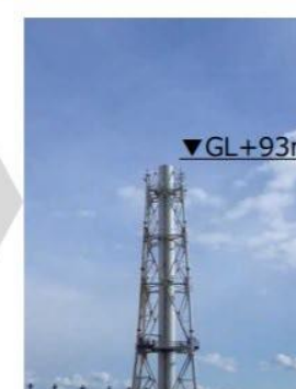
11ブロック解体後 (2020年2月4日)
