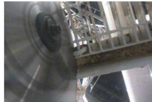
12ブロック目鉄塔解体作業(2月24日)
