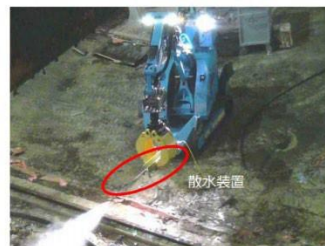
① 散水状況(ダスト抑制対策)
