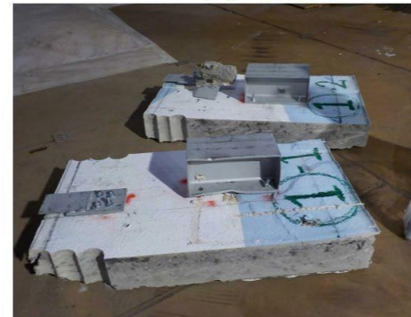
壁解体 (STEP6) 2018/5/28撮影
