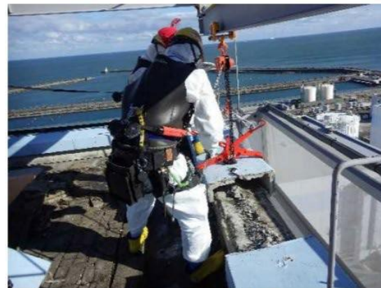
屋上での桁木撤去状況
