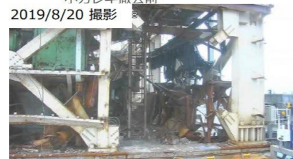
南側小ガレキ撤去後
