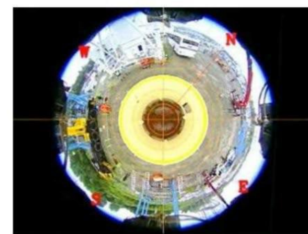
装置据付け時のカメラ画像
