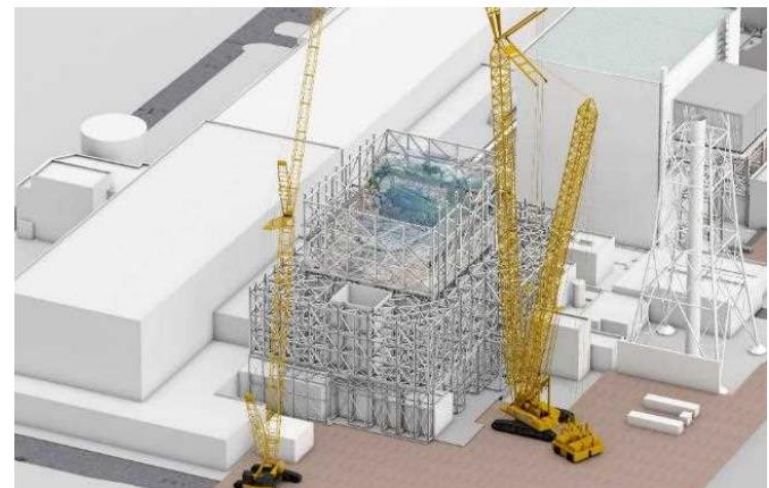
下部架構設置完了
