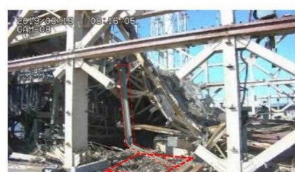
小ガレキ撤去前
