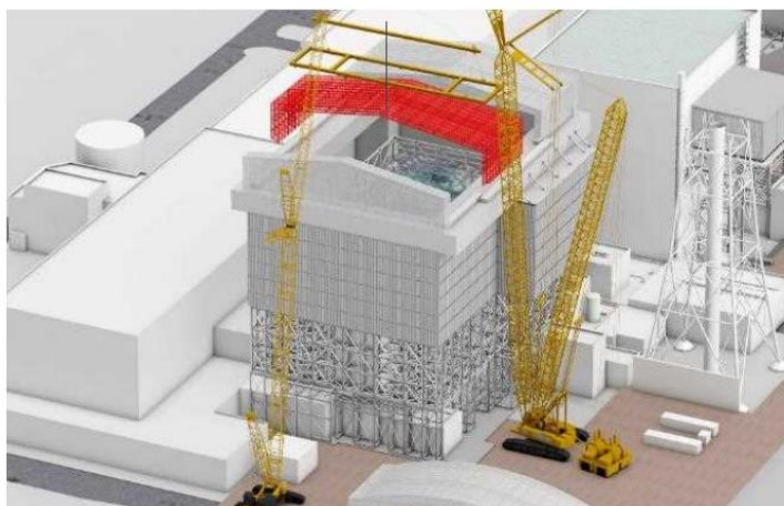
可動屋根設置中
