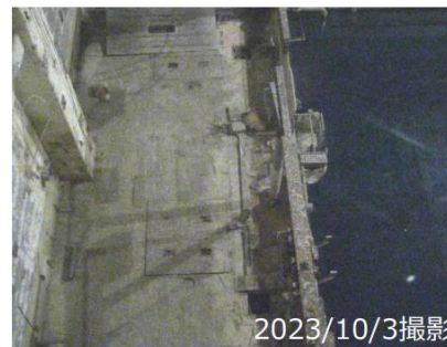
除染実施後の状況 (南面)
