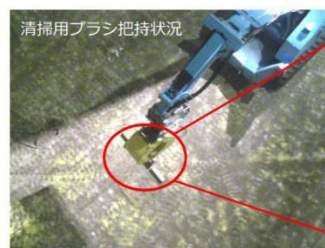
清掃用ブラシを用いて、床面の遊離性ダスト(砂等)を集め、集塵機で回収を行う。
