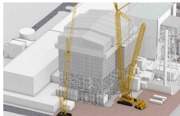
可動屋根設置完了
