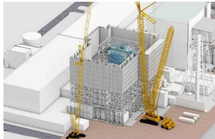
上部架構設置完了
