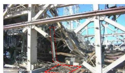
小ガレキ撤去前
