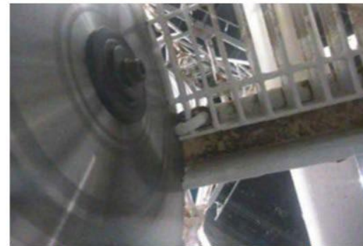
12ブロック目鉄塔解体作業(2月24日)
