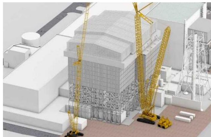
可動屋根設置完了
