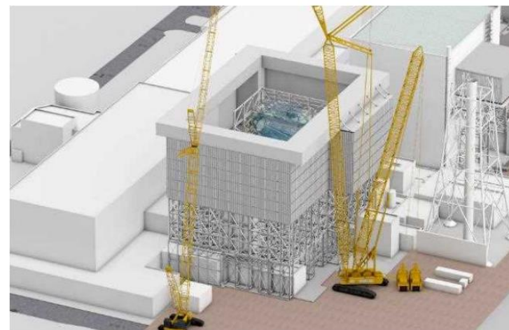
ボックスリング設置完了
