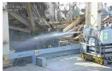
飛散防止剤散布状況
