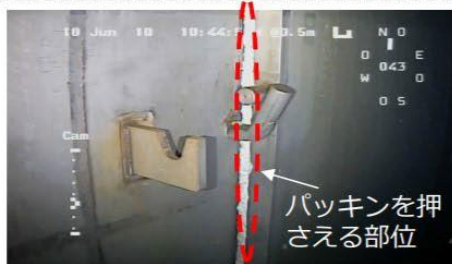
プールゲート支持軸の様子
