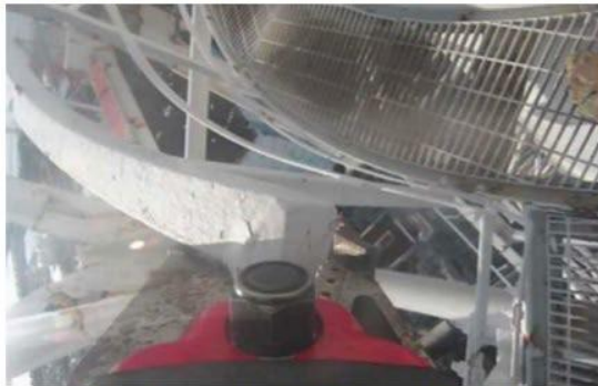
12ブロック目鉄塔解体作業(2月24日)
