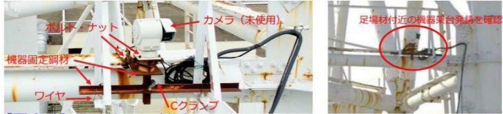
【写真①】北面約42m付近 【参考】臨時点検時の写真（2019年1月撮影）
