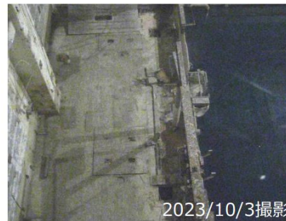
除染実施後の状況 (南面)
