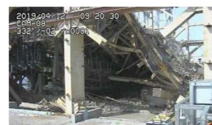
小ガレキ撤去状況
