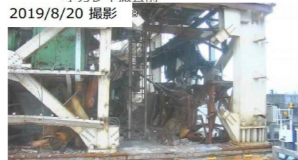
南側小ガレキ撤去後
