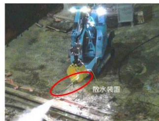
① 散水状況 (ダスト抑制対策)
