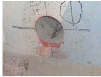
調査用コア採取の状況
