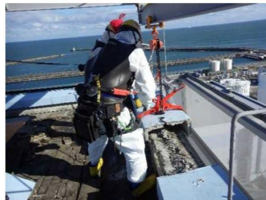
屋上での笠木撤去状況
