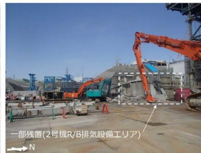
共用ボイラ建屋解体後(2020年3月撮)
