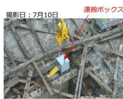
写真① 運搬ボックス設置状況
