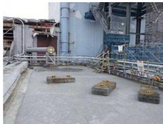
FSTR建屋片付け状況
