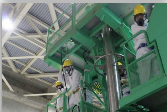
共用プールにおける作業の状況
