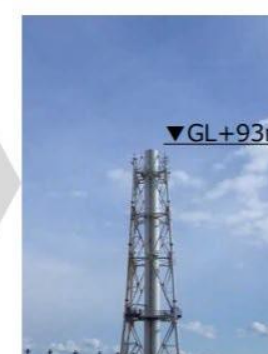
11ブロック解体後 (2020年2月4日)
