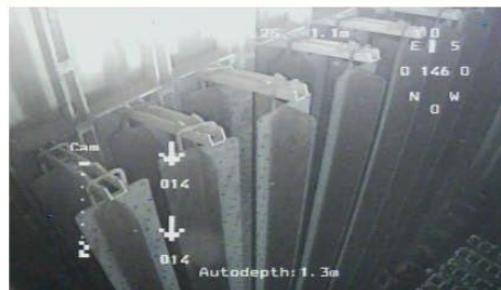
制御棒ハンガー（北東側）の様子
