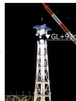
11ブロック解体時 (2020年2月1日)
