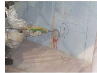
調査箇所の孔塞ぎ状況
