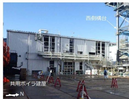
共用ボイラ建屋解体前 (2019年12月撮影)
