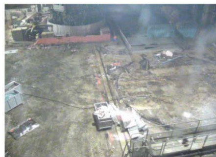
②残置物片付後 (北側) 撮影日(10/22)
