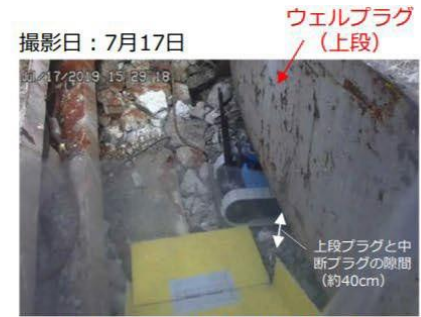
写真② 内部への侵入状況 (運搬ボックス内のカメラから撮影)
